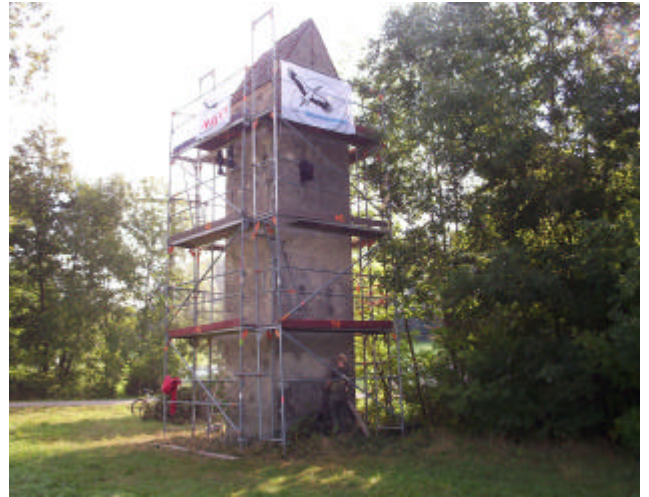
Unübersehbar tut sich was an der NABU-Trafostation bei der Stegmühle. Die Aktiven Mitarbeiter des NABU Aspach haben das Gerüst aufgestellt.
