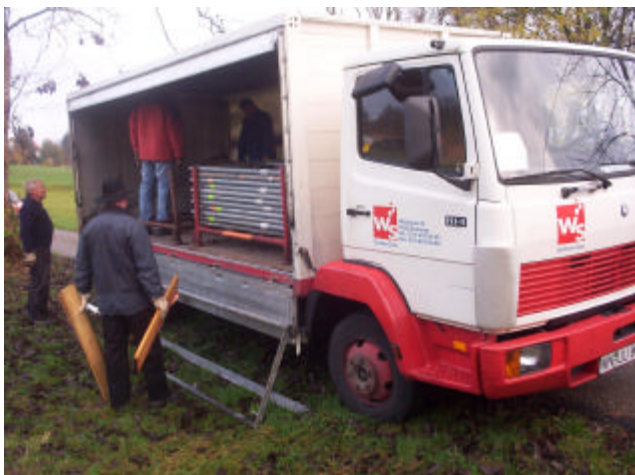
Mit vereinten Kräften wurde das Gerüst wieder abgebaut.
